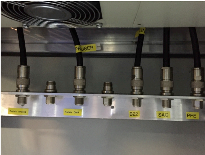
Verkabelung neu verlegen (Koaxkabel)
