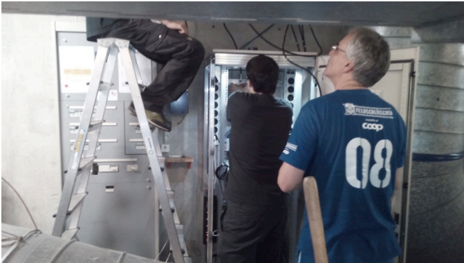
Verkabelung neu verlegen (Koaxkabel)
